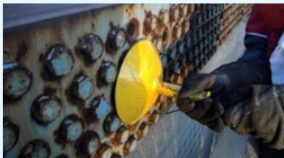
Figure n°2: système anti éjection tenu à la main avec dispositif écran.
