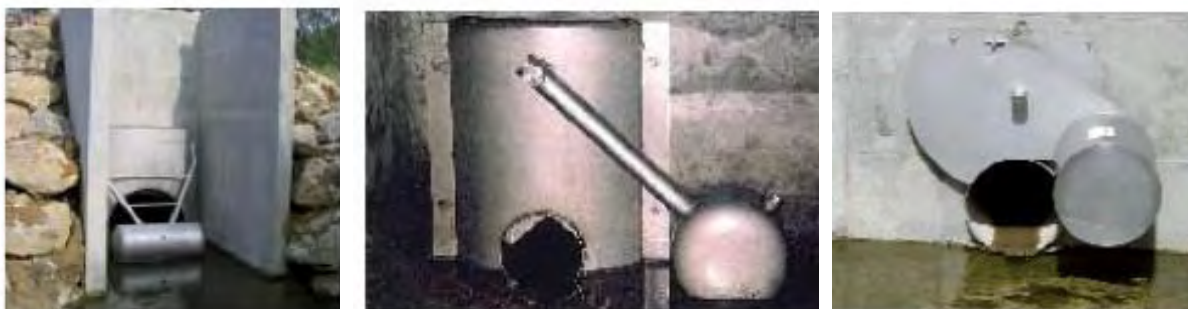
Figure 126 : Régulateurs à flotteur (Saint Dizier environnement)
