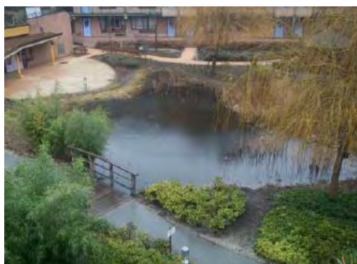
Figure 44 : Marre d'infiltration (Rombaut, 2010)
