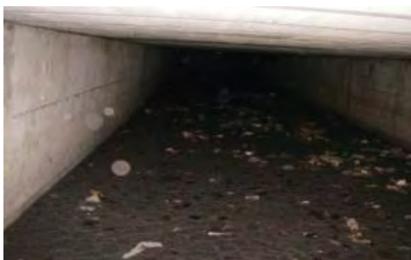
Figure 67 : Bassin enterré – Photo (Communauté Urbaine de Bordeaux, 2014)
