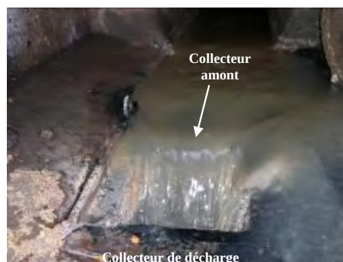
Déversoir à trou dans le radier ou « leaping weir »
