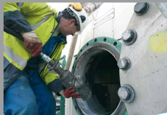
→ Nettoyage d'un bac pétrolier sous très haute pression
