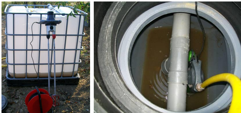
Figure 1 : A gauche : Cuve de stockage des eaux brutes pompées sur une période de 24h ; A droite : pompe eau chargée dans le regard de réception des eaux brutes
