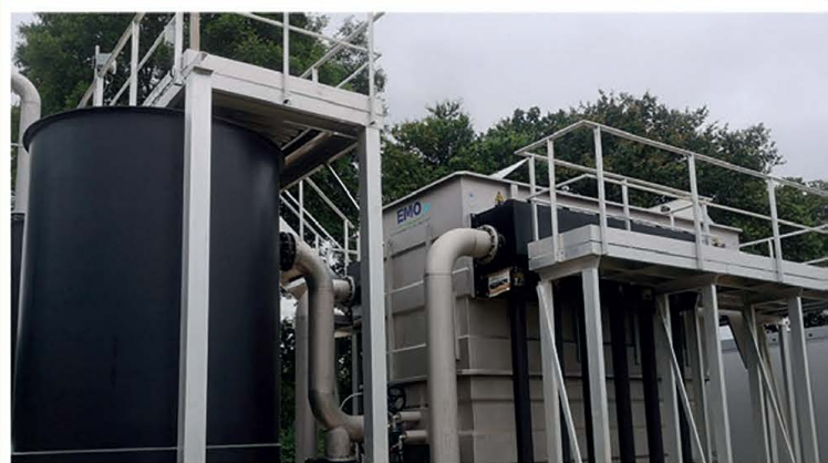
Unité de traitement d'effluents industriels FLOTTATEUR A AIR DISSOUS
